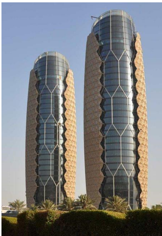
Рис. 29. Башти Aedas Architects Al Bahar в Абу-Дабі – приклад кінетичних фасадів. Парасолькові панелі фасаду відкриваються та закриваються у відповідь на рух сонця, захищаючи користувачів будівлі від спеки та відблисків, зменшуючи потребу в кондиціонуванні повітря та роблячи будівлю більш стійкою. Самі панелі не тільки естетичні та зіркоподібні за дизайном, а й навіяні традиційними ісламськими системами затінювання, які також поважають культурну спадщину
