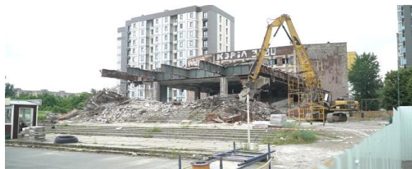
Рис. 6. Демонтаж кінотеатру «Салют» в м. Дніпро
