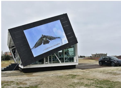
Рис. 4. Фото будинку компанії Casas em Movimento
