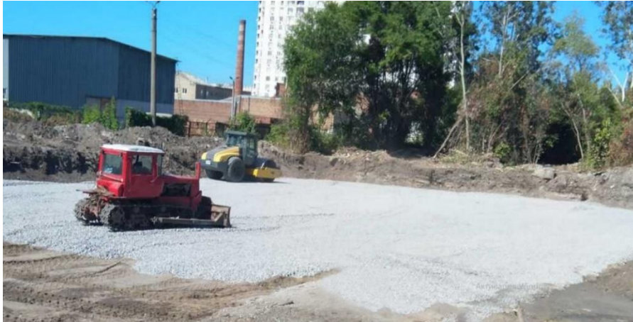
Рис. 4. Етап підготовки основ фундаментів
