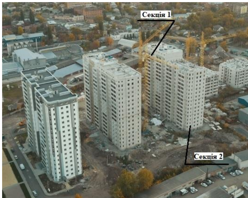
Рис. 1. Розташування дослідної будівлі 7 (секції 1 та 2) у процесі зведення
