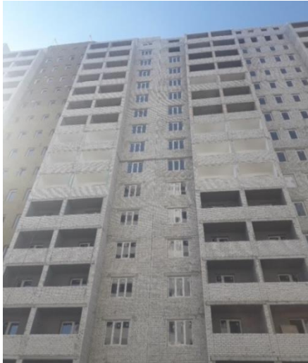
Рис. 9. Деформаційний шов на завершальному етапі будівництва
