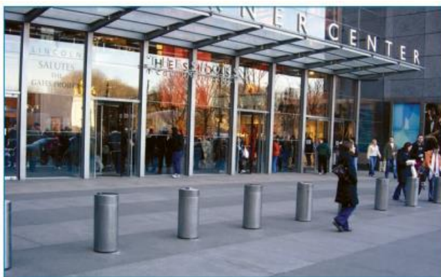
Рис. 1. Сталеві боларди як захисні охоронні конструкції
