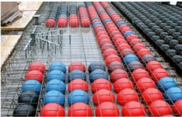
Рис. 2. Фрагмент кріплення на поверхні опалубки арматурних каркасів з порожнистими пластиковими кулями
