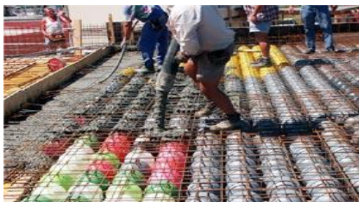
Рис. 2. Бетонування перекриття з пустотоутворювачами з пластикових куль
