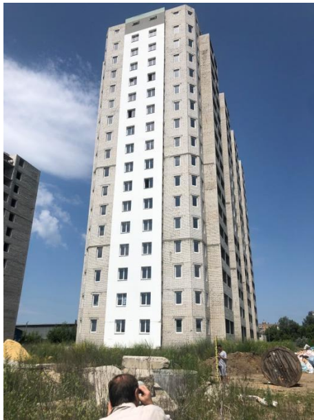
Рис. 16. Загальний вигляд будівлі та деформаційний шов на завершальному етапі будівництва
