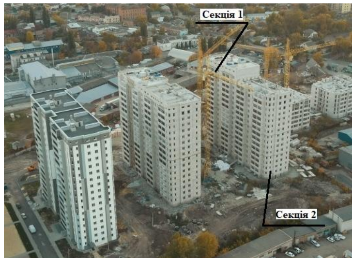
Рис. 3. Розташування дослідної будівлі 7 (секції 1 та 2) в процесі зведення
