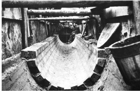
Рис. 1. Каналізаційний колектор у Харкові по вул. Греківській у процесі будівництва
