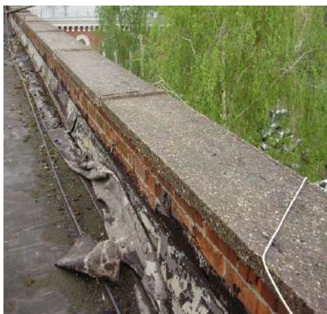
Рис. 6. Пошкодження примикання шарів руберойду до парпету
