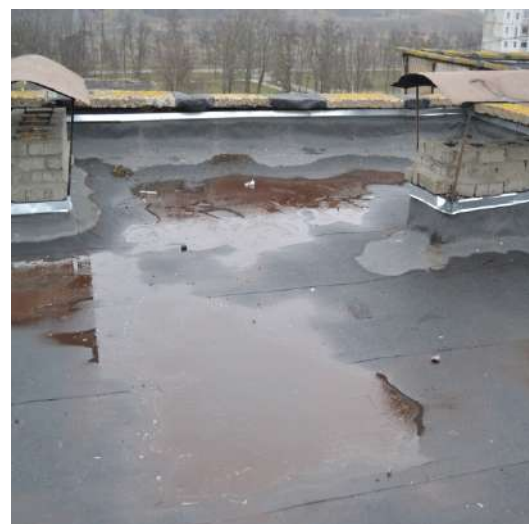
Рис. 3. Скупчення води на існуючій рулонній покрівлі
