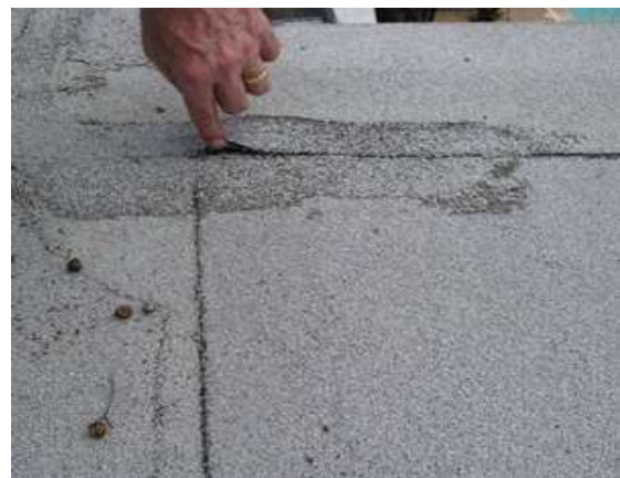
Рис. 2. Відшаровування в зонах напусту килима
