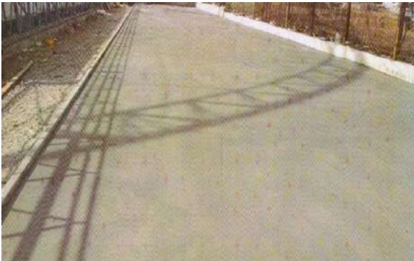
Рис. 2. Бетонне дорожнє покриття паркувального майданчика після завершення робіт
