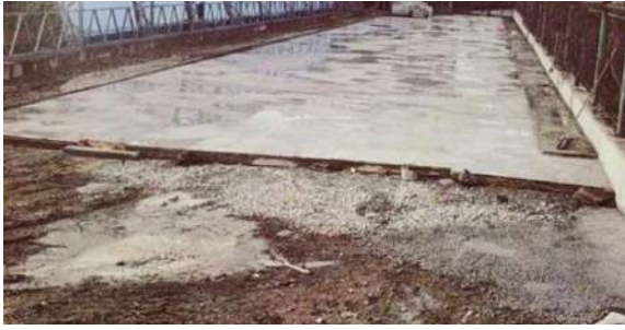
Рис. 1. Бетонне дорожнє покриття паркувального майданчика під час його влаштування
