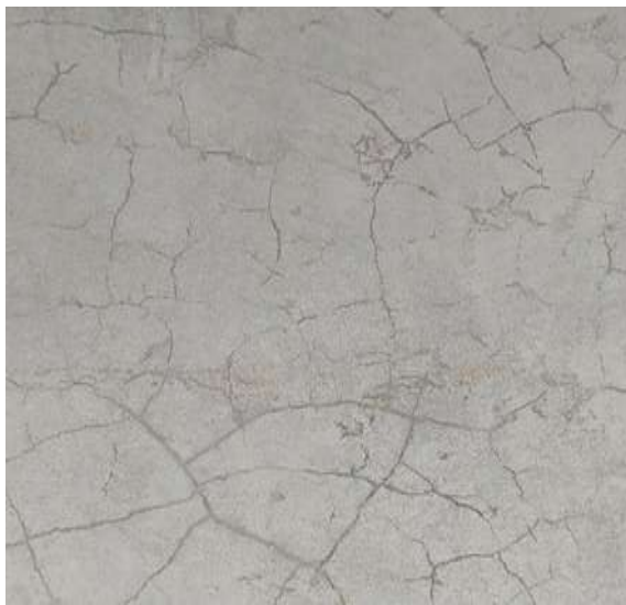
Рис. 3. Дефекти бетонного дорожнього покриття паркувального майданчика: а – павутиння тріщин на бетонній поверхні; б – «неорганізовані» деформаційні шви
