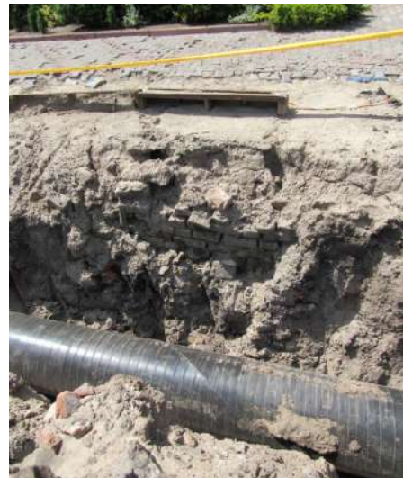
Рис. 11. Залишки зливоприймачів, виявлені під час земляних робіт на площі Шевченка перед центральним входом у парк ім. Т. Г. Шевченка
