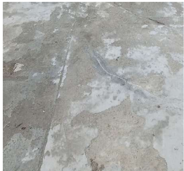
Рис. 3. Дефекти бетонного дорожнього покриття паркувального майданчика: а – павутиння тріщин на бетонній поверхні; б – «неорганізовані» деформаційні шви
