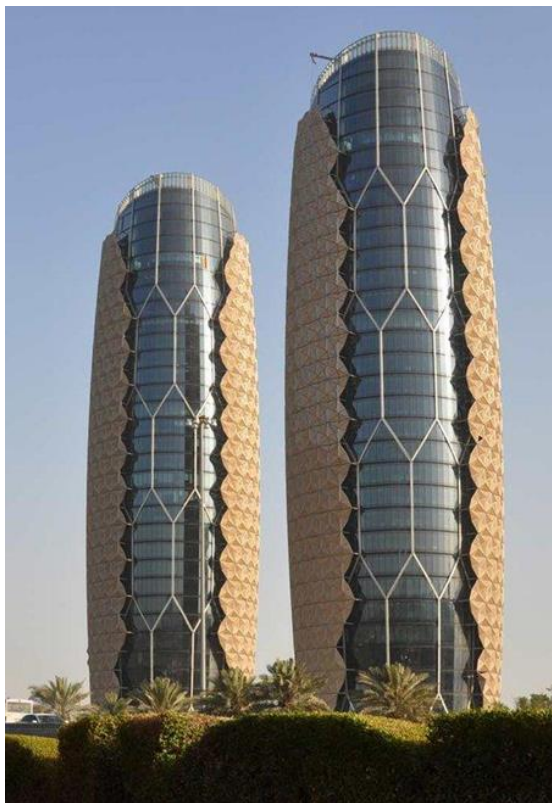
Рис. 29. Башти Aedas Architects Al Bahar в Абу-Дабі – приклад кінетичних фасадів. Парасолькові панелі фасаду відкриваються та закриваються у відповідь на рух сонця, захищаючи користувачів будівлі від спеки та відблисків, зменшуючи потребу в кондиціюванні повітря та роблячи будівлю більш стійкою. Самі панелі не тільки естетичні та зіркоподібні за дизайном, а й навіяні традиційними ісламськими системами затінювання, які також поважають культурну спадщину
