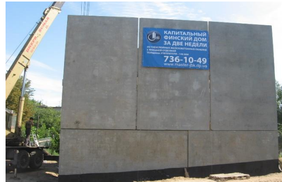
Рис. 3. Будівництво котеджу зі збірних тришарових залізобетонних панелей за фінською технологією
