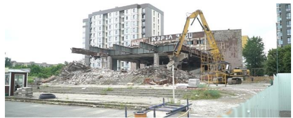
Рис. 6. Демонтаж кінотеатру «Салют» в м. Дніпро
