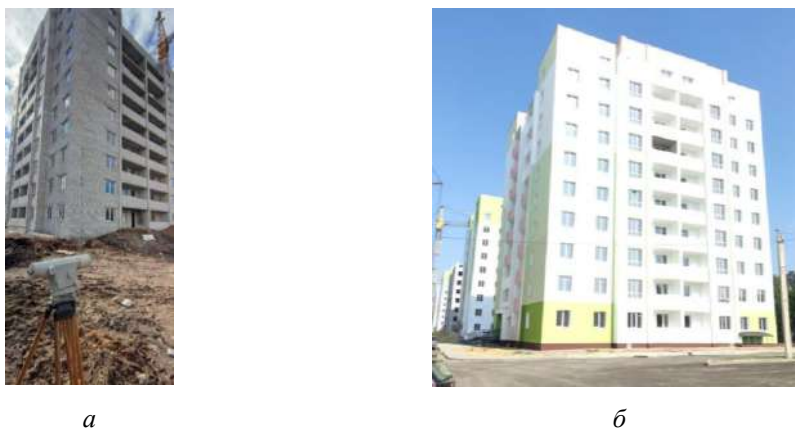
Рис. 5. Види будівлі: а – в процесі будівництва; б – в процесі експлуатації
