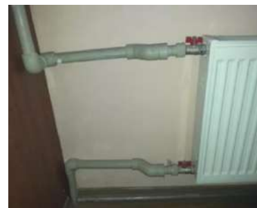
д) часткова заміна трубопроводів системи опалення
