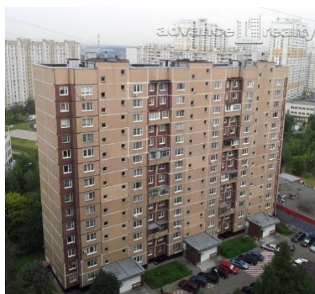
Рис. 6. Великопанельний житловий будинок
