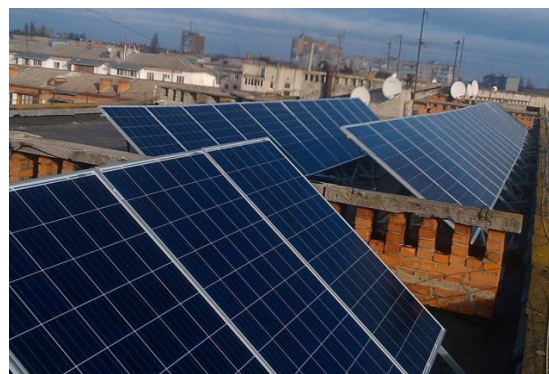
Рис. 2. Встановлення сонячних панелей на плоскому даху
