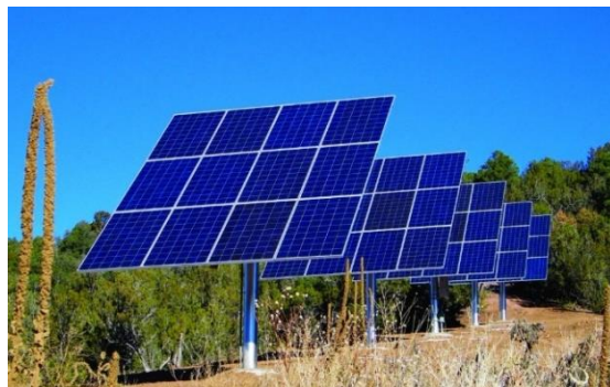
Рис. 1. Встановлення сонячних панелей на землі
