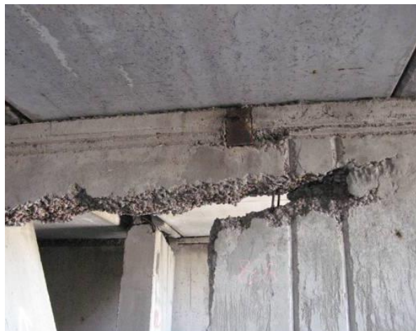
Рис. 4. Руйнування бетону конструкцій стін та вилучення арматури
