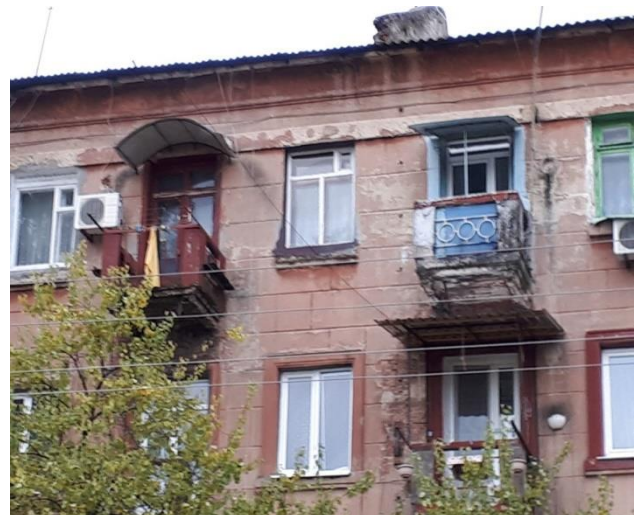
Рис. 2. Типове пошкодження цивільного будинку: тріщини, сколи, корозія бетону та металевих елементів
