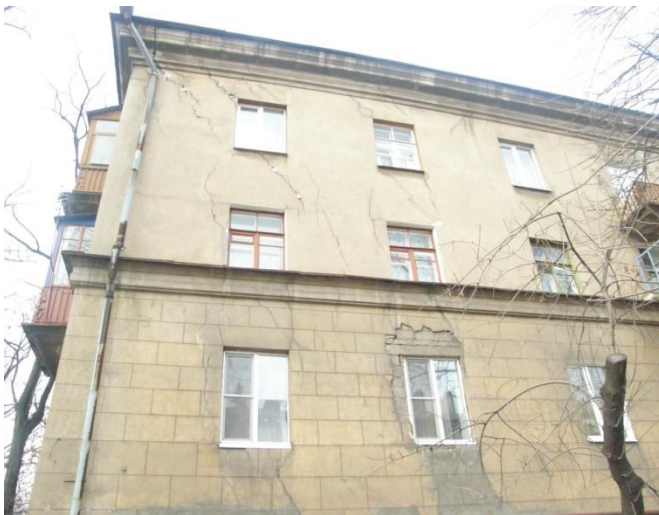
Рис. 2. Типове пошкодження цивільного будинку: тріщини, сколи, корозія бетону та металевих елементів
