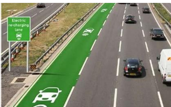
Рис. 4. Електрифікована смуга руху на автомобільній дорозі
