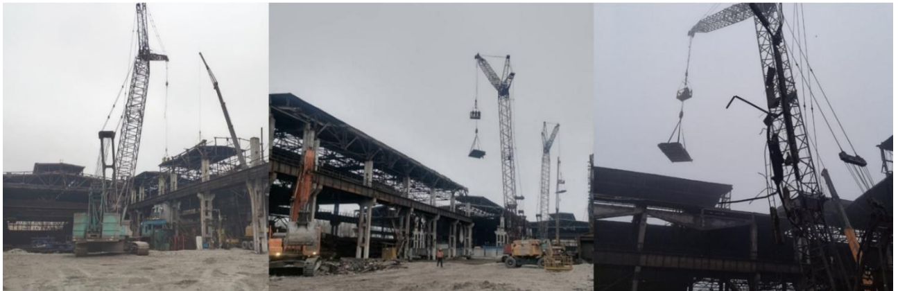
Рис. 13. Фото демонтажу аварійних плит покриття
