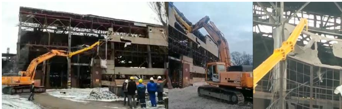
Рис. 10. Фото виконання робіт
