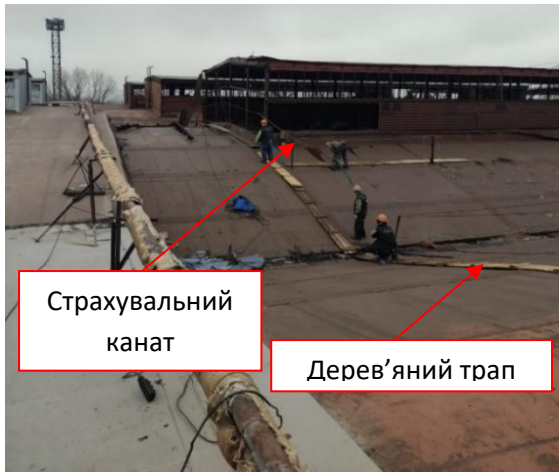
Рис. 16а. Схеми встановлення трапів
