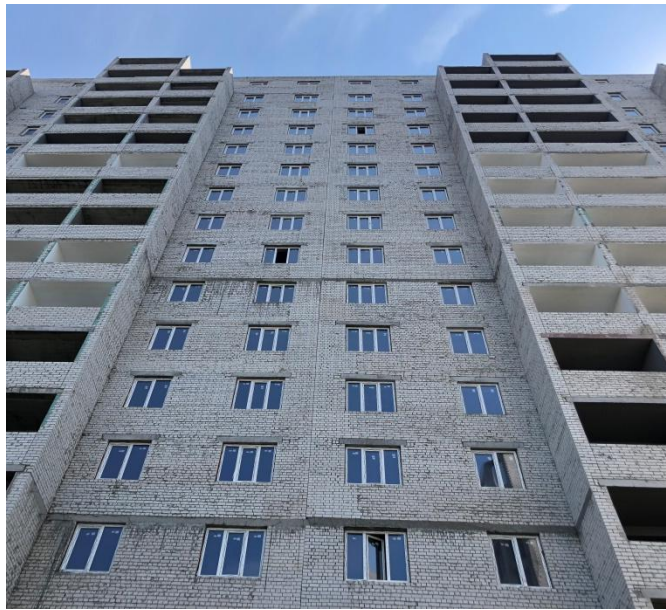
Рис. 16. Загальний вигляд будівлі та деформаційний шов на завершальному етапі будівництва
