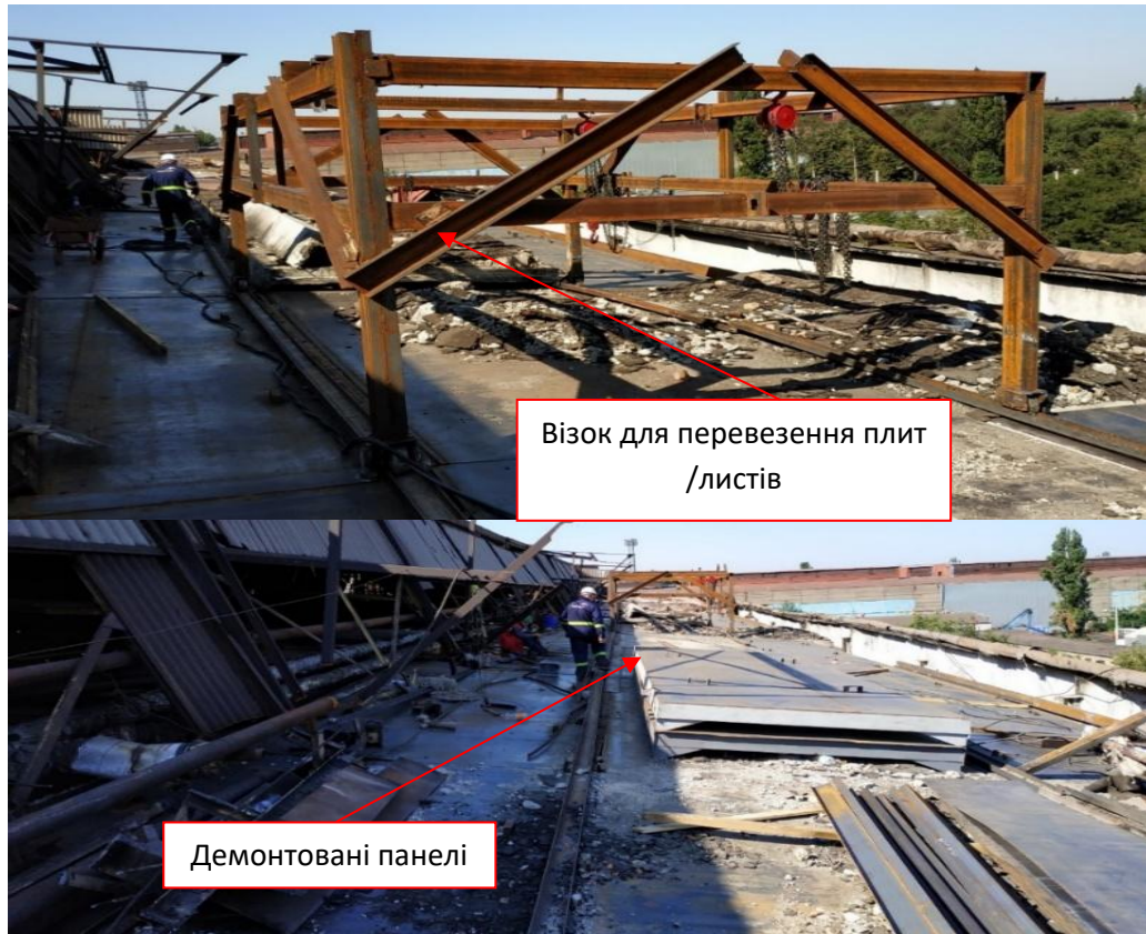
Рис. 17. Фото демонтажу покрівлі за допомогою спеціального візку
