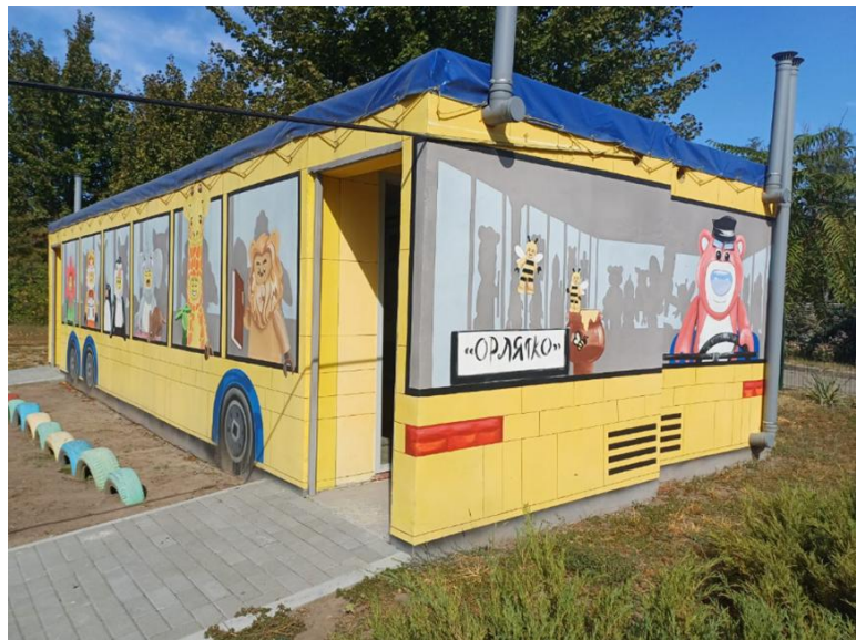
Рис. 2. Загальний вигляд модульної захисної споруди
