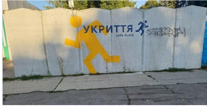
Рис. 1. Суцільна залізобетонна конструкція під назвою «Укриття»
