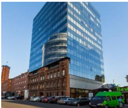
Рис. 10. «Історична маска» фасаду колишнього прибуткового будинку після реконструкції (м. Дніпро, вул. Глінки, 7)
