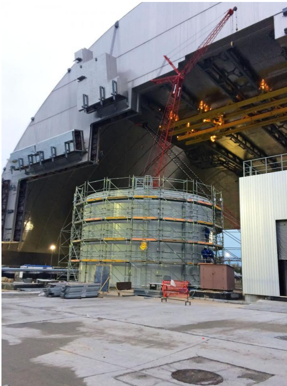
Рис. 1. Зведення резервуарів на ДСП «Чорнобильська АЕС»
