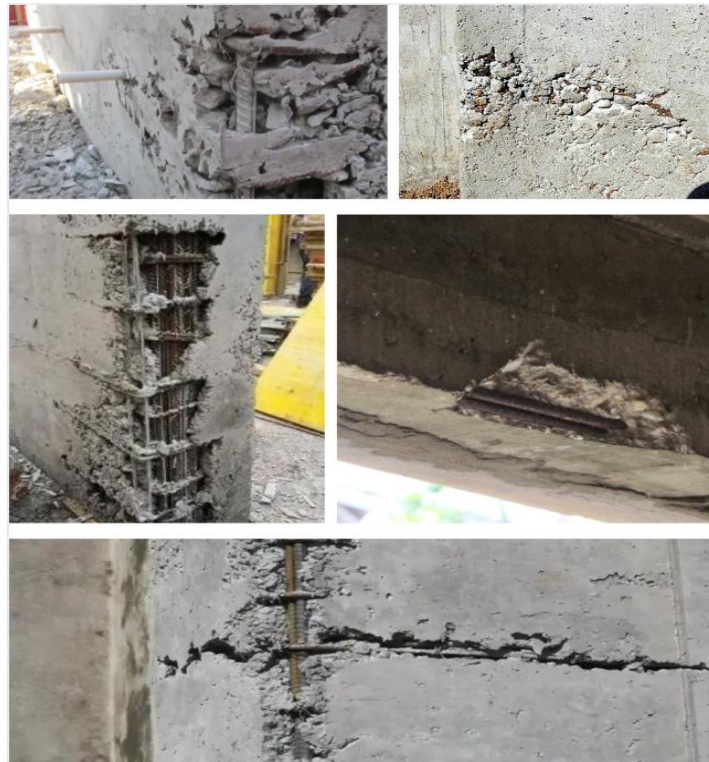
Рис. Найбільш поширені види браку в каркасно-монолітних конструкціях
