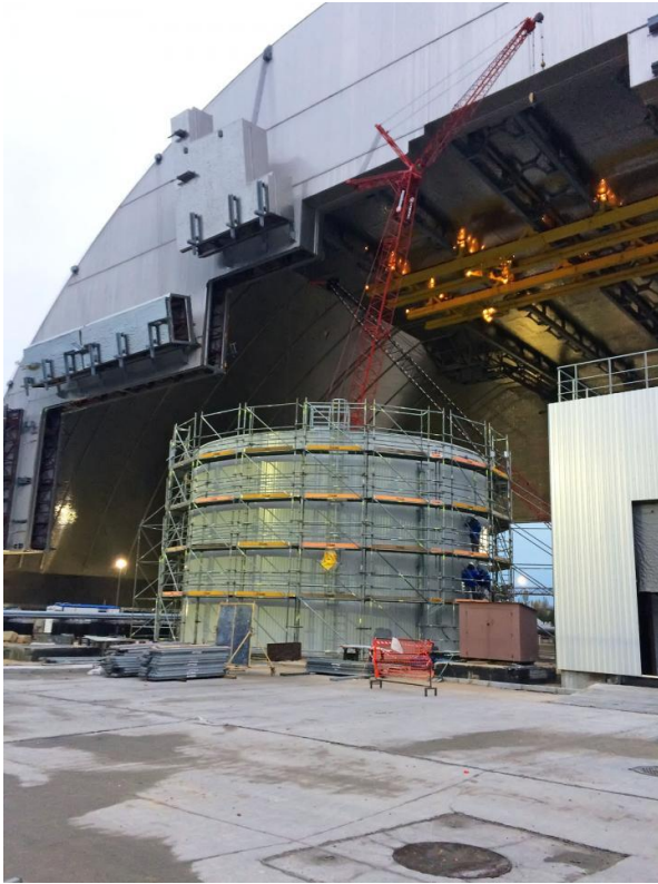
Рис. 1. Зведення резервуарів на ДСП «Чорнобильська АЕС»
