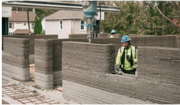
Рис. 2. Зведення приватного будинку із застосуванням будівельного 3D-принтера компанії COBOD
